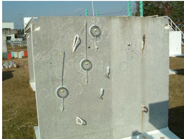
写真－Ⅳ.1.1 現場透水試験器具の試験状況
